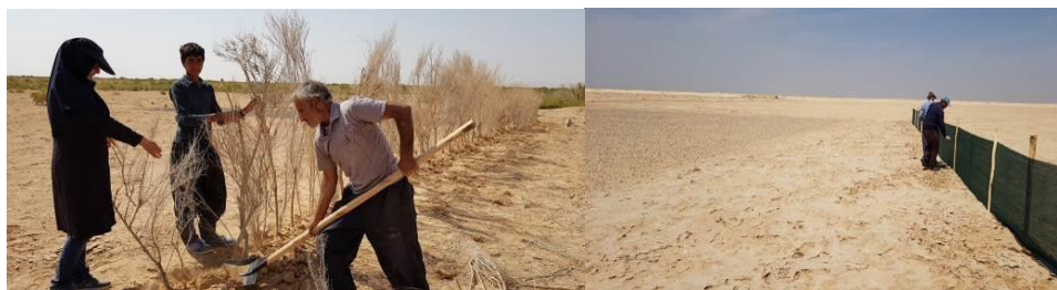
شکل ۳- ایجاد بادشکن با سرشاخه های تاغ و توری در اطراف محدوده پاشش سرباره ها در سایت ۱ و ۲
